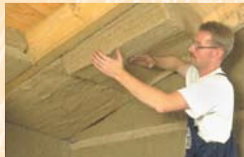
Wand- und Deckendämmung
